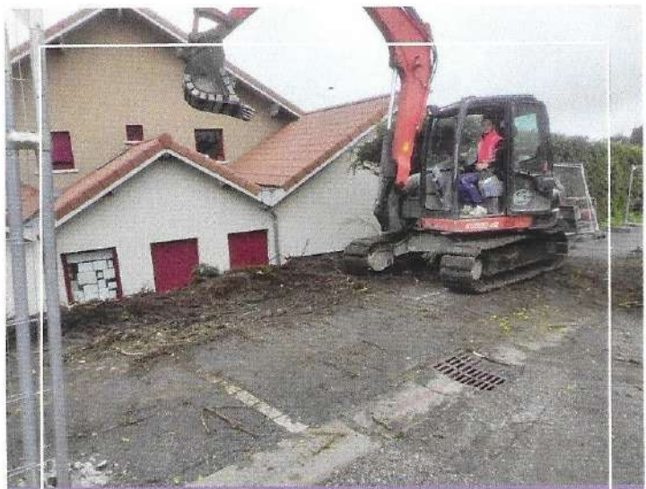
Début des travaux
