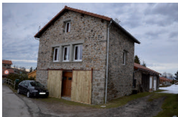
Exemple d'architecture du XIX ème siècle : granit, enduits à dominante gris-beige, percements verticaux, pente de toiture 40% et tuiles canal à dominante rouge.
