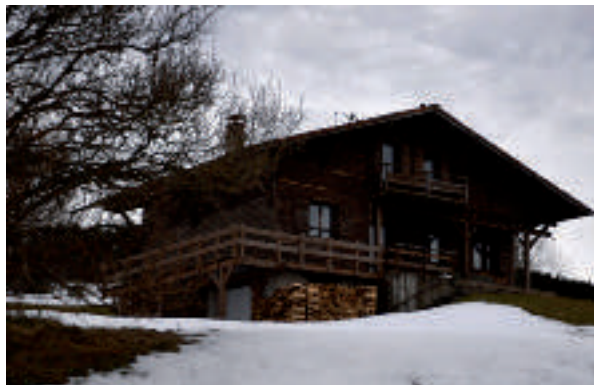
Exemple d'architecture du XX ème siècle, de type « chalet » : faitage dans le sens de la petite dimension, couleur du bardage sombre, pente de toiture 40-50%.
