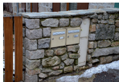
Exemple de boîte aux lettres et de logette électrique intégrées à la clôture
