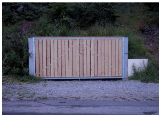
Exemple de local pour transformateur électrique
