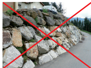
Exemple d'enrochements de type cyclopéen
