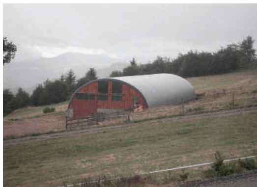
Exemple de tunnel agricole de teinte grise
